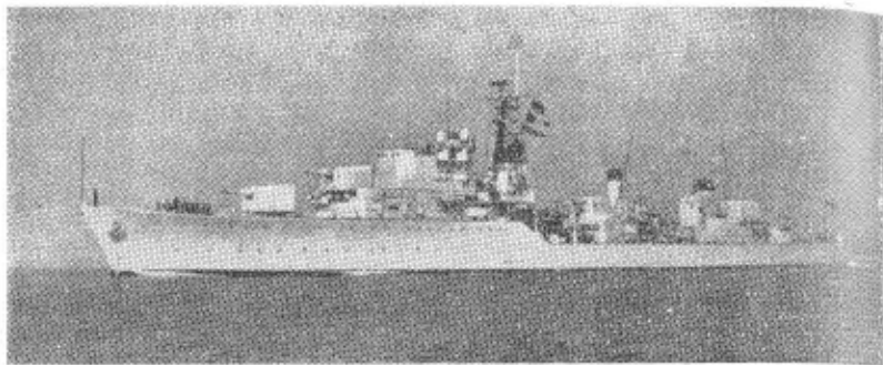
Brittiska jagaren »Diamond» tillhörande »Daring»-klassen. Depl. — 2.610 tons std och 3.700 tons fullt rustad. Turbinmaskineri om c:a 55.000 hk ger en högsta fart av 35 knop. Bestyckning: 6—11,5 cm kan i dubbeltorn, 6—40 mm akan, 10—53 cm torpedtuber, 1-squid-lavettage. (Engineer).
