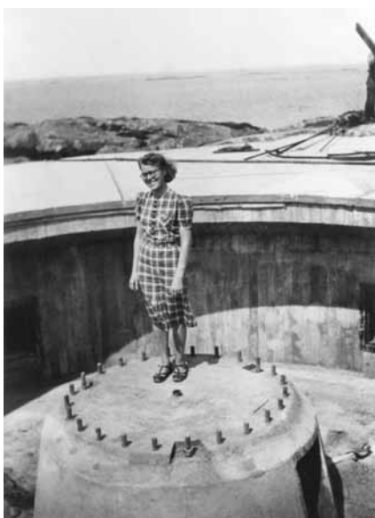
Kökar juni 1940: Kanonställning byggd av Skånska Cementgjuteriet och avsedd för 152 mm pjäs av typ Canet. Den glada damen är troligen fortchefens fru.
