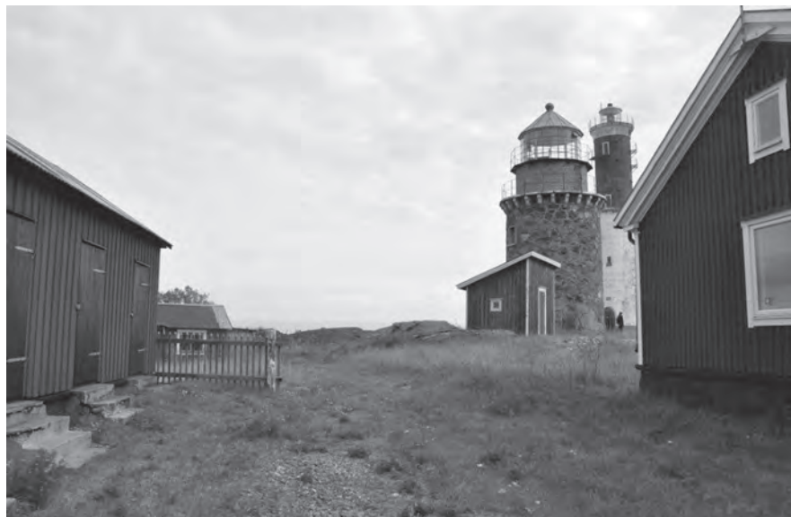
Understen 2016. Foto: Kustbevakningen.
